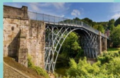
Pierwszy na świecie most żelazny w Coalbrookdale (czyt. Kollbrukdejł) na rzece Severn, ukończony w 1779 r.
